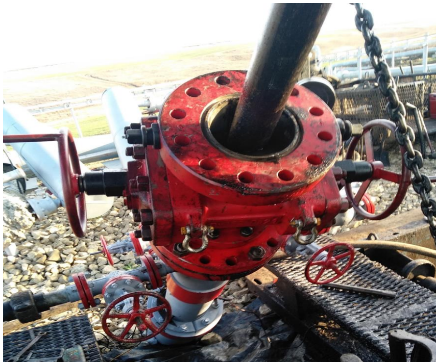
Рисунок 3.3 – Загерметизированное наклонное устье скважины СВН
