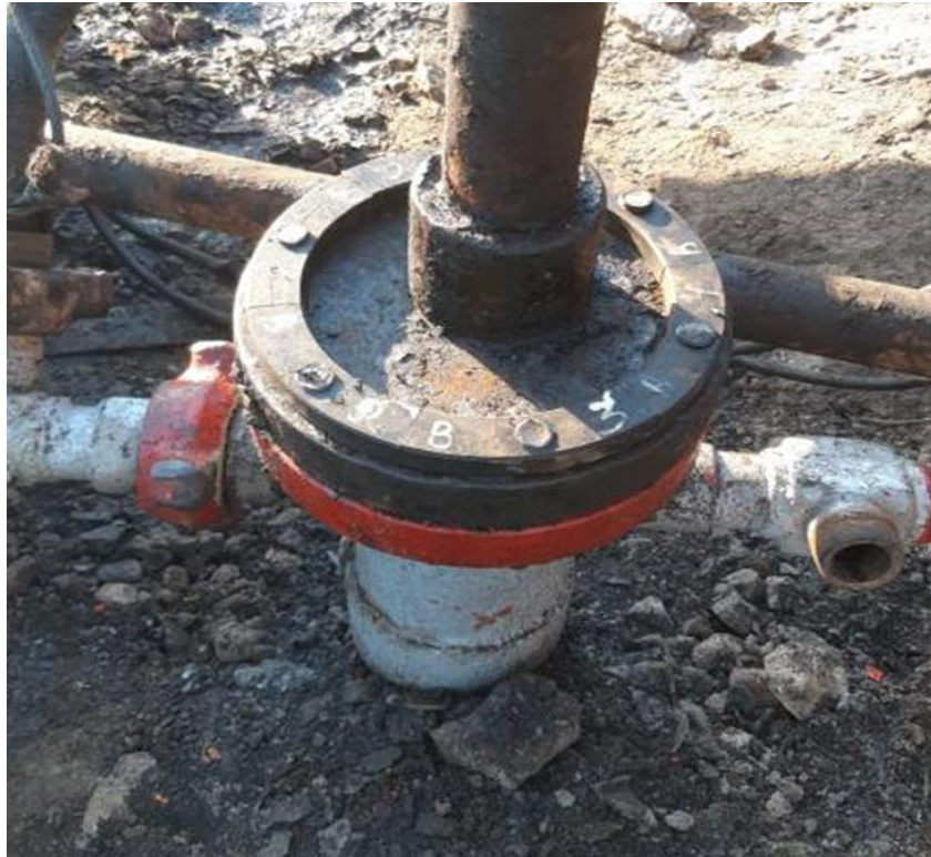
Рисунок 3.22 – Монтаж/демонтаж крепления КФ-6 на устьевой арматуре
