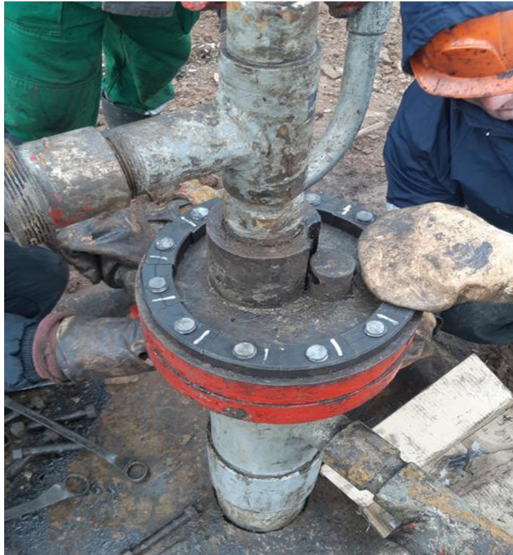
Рисунок 3.23 – Монтаж/демонтаж крепления КФ-12 на устьевой арматуре
