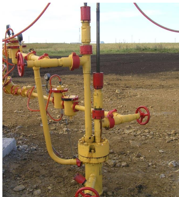
Рисунок 1.6 – Двухствольная арматура а- схема арматуры; б- вид арматуры на скважине
